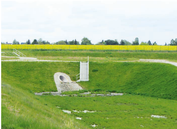
Regenrückhaltebecken, Flughafen BER, Berlin-Schönefeld (Quelle: Berliner Wasserbetriebe)
